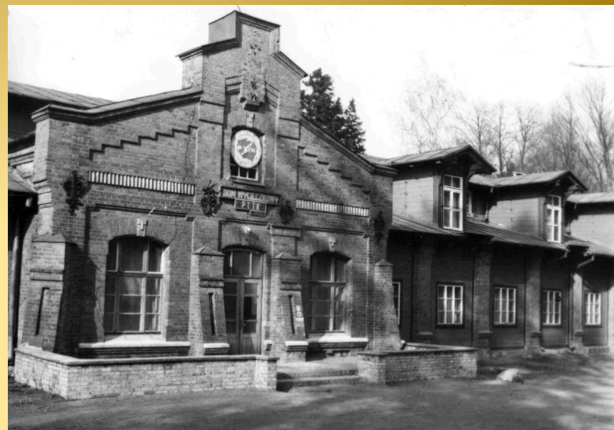
Budynek dawnej stajni carskiej W okresie międzywojennym schronisko turystyczne Miejsce odbywania się I i II kursu dla leśniczych
